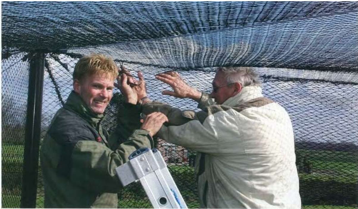
Een volière dak van 1000 m 2 van nylongaas met veel spankabels en vlechtwerk vraagt uren werk, geduld en vakmanschap. Links eigenaar Jack Evers op de steiger.
