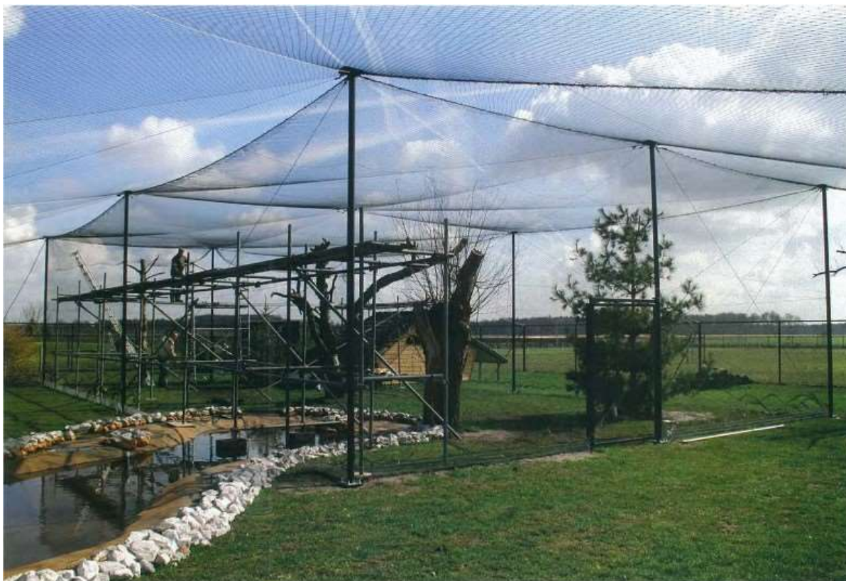
In de mega-volière van Jack en Carla Evers in het West-Brabantse Sprundel, 25 x 40 meter grondoppervlak, is met fijnmazig gaas een volièrre gemaakt voor kleinere vogelsoorten. Hier staan de steigers nog in de 'kleine' volièrre. In de buitenste ring om deze volièrre verblijven grotere vogelsoorten.
